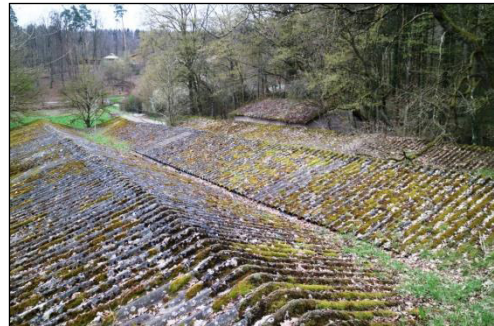
Dachflächen der Gebäude
